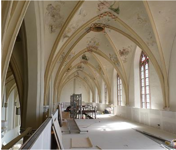
Afb.21 De plafondschilderingen tijdens de verbouwing 94
